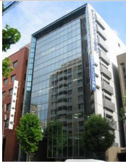
本町通りから見た外観
