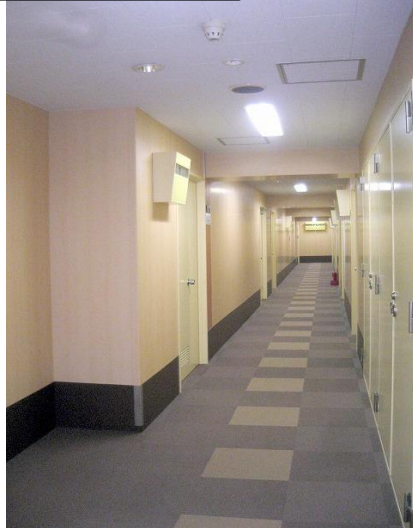
2008年に大規模修繕を実施した共用廊下
